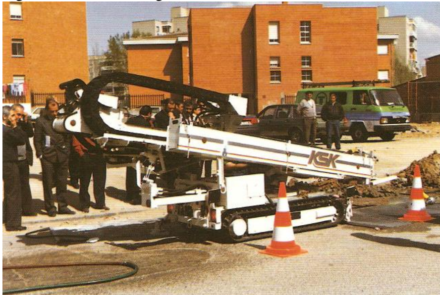
Fig. 5.8 Perforación dirigida. Torre de perforación
