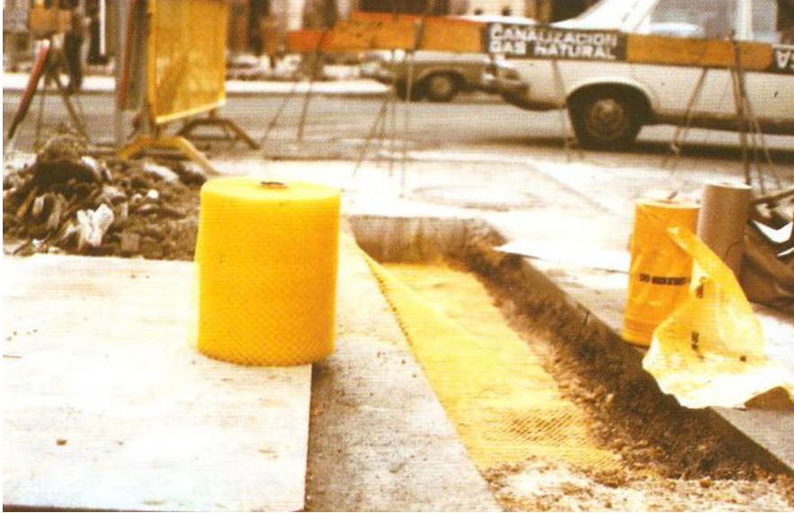
Fig. 5.12 Señalización de tubería. Banda y malla
