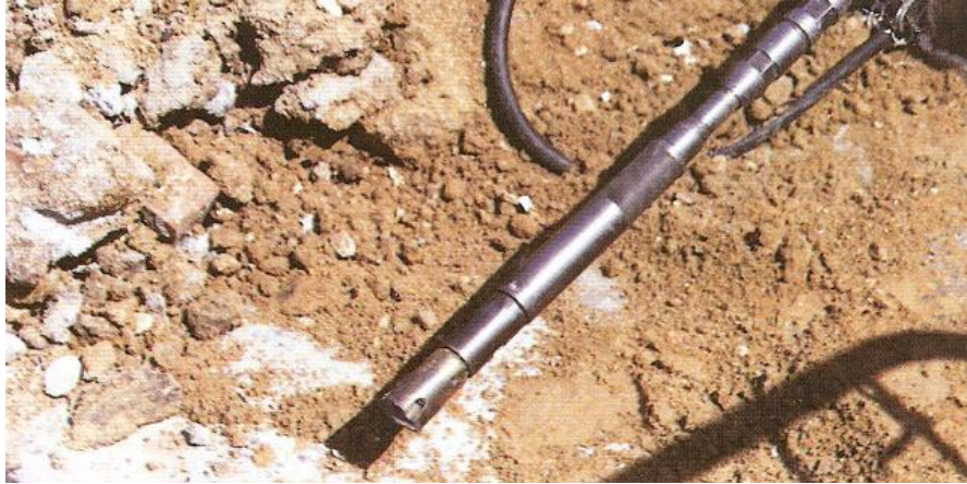
Fig. 5.9 Perforación dirigida. Cabeza de perforación
